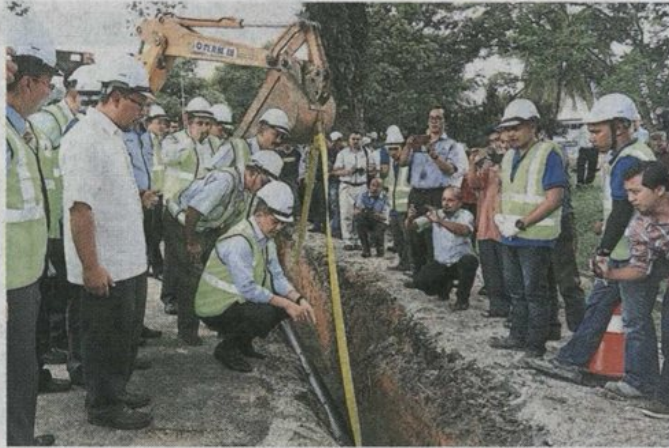
■阿兹敏阿 (身穿荧光衣蹲著者) 巡视美拉瓦迪花园更换旧水管工程。
